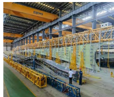
现腹板加压工装方式
