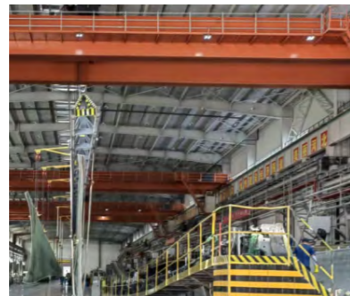
原腹板一字梁及吊带吊装方式
